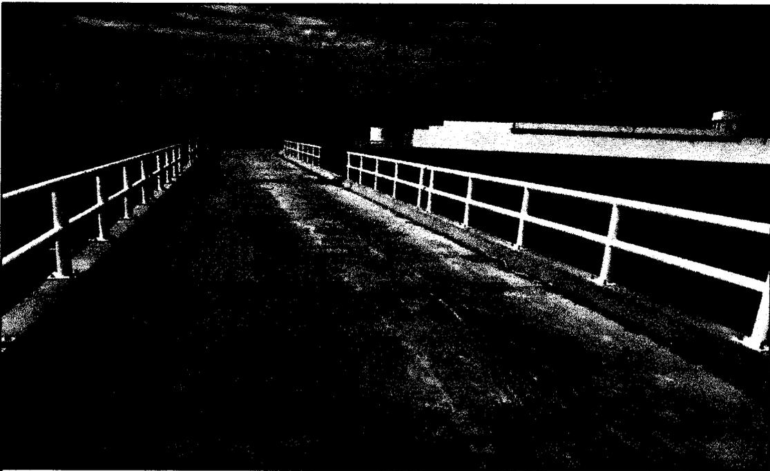
**Imagen N°04: Instalación de barandas de tubería de acero**
